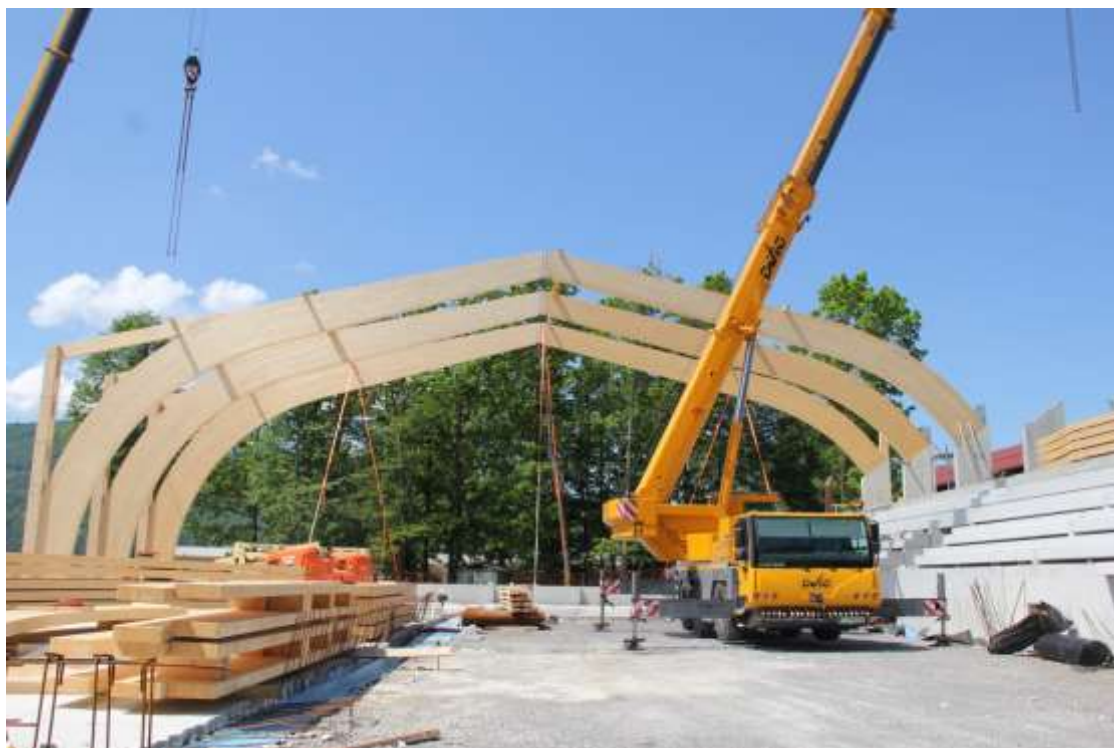
Slika: JVIZ OŠ Dobropolje, gradnja športne dvorane, junij 2019
