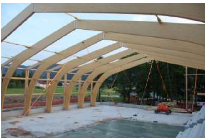
Gradnja športne dvorane
